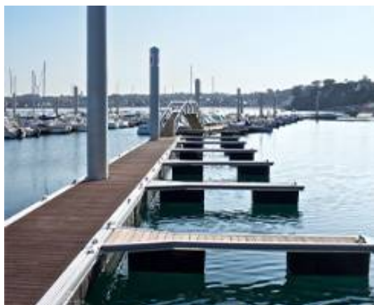
Imagem 03 Pier Flutuante em Alumínio
