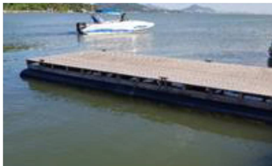
Imagem 01 Pier Flutuante em PEAD
